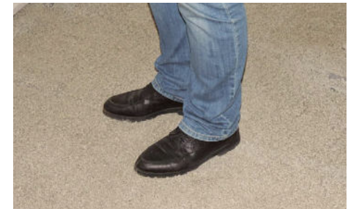
Bei optimalen Witterungsbedingungen (Luftfeuchtigkeit, Temperatur etc.) nach ca. 24 Stunden begehbar.
